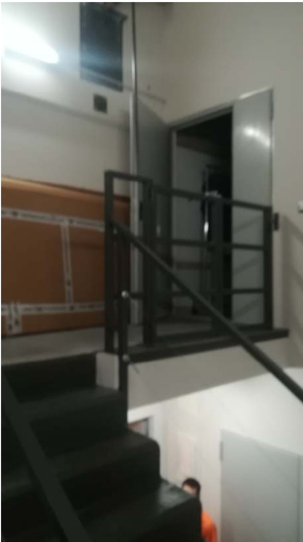
Accés dipòsit núm 2
